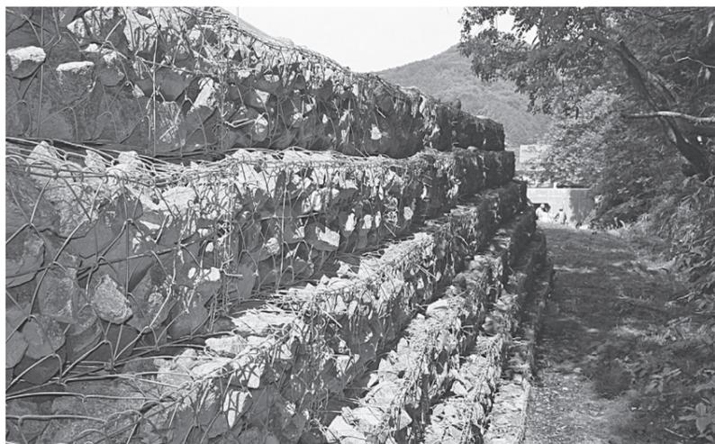
従来、石詰めかごは空かごを設置した後に、石詰め作業をしていたが、ボックスストーン工法は、最初から石詰めされたプレキャスト石詰ふとんかごを設置する画期的な工法である。この工法によると、平地で重機による石詰作業ができるため、高い安全性の確保や可搬性が高いため所要量の施工前ストックが可能であり、工期が大幅に短縮されることや、充填用骨材プラントにて製造することにより、従来現場施工では避けられなかった充填用骨材のロスの削減、機械主体への変換により労働環境が格段に改善、これまで係数化できなかった
